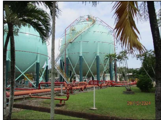
ภาพถ่ายที่ 2.2-21 ระบบฉีดน้ำดับเพลิง บริเวณถังเก็บก๊าซปิโตรเลียมเหลว
