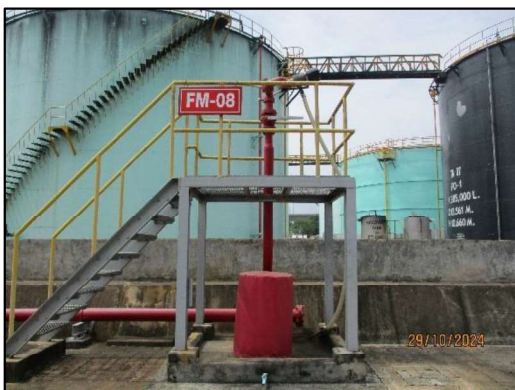
ภาพถ่ายที่ 2.2-24 ระบบฉีดน้ำดับเพลิงแบบโฟม
